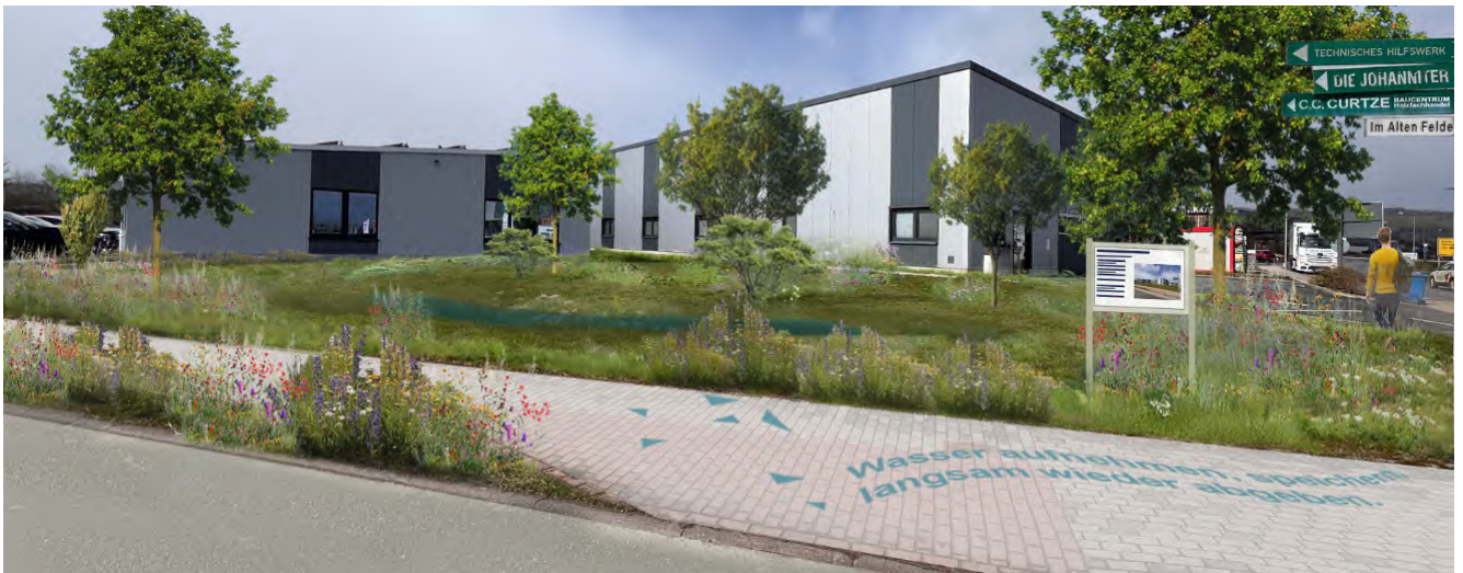
Abb. 61: Infotafel und Bodenmarkierungen am neuen Retentionsbecken
