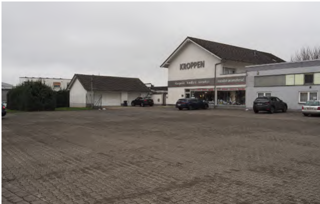
Abb. 2: Große versiegelte Parkplatzflächen
