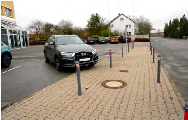
Abb. 4: Großer versiegelter Bereich
