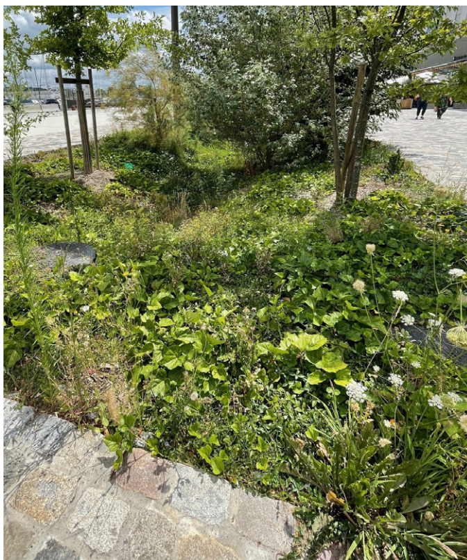
Beispielbilder Versickerungsmulde (Fotos: Beatrix Baltabol)
