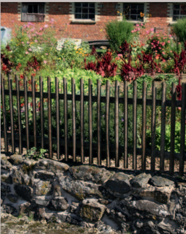
Lattenzaun auf Bruchsteinmauer
