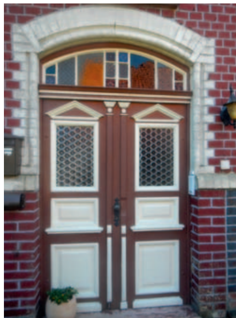
Wärmetechnisch verbesserte Tür aus dem Historismus
