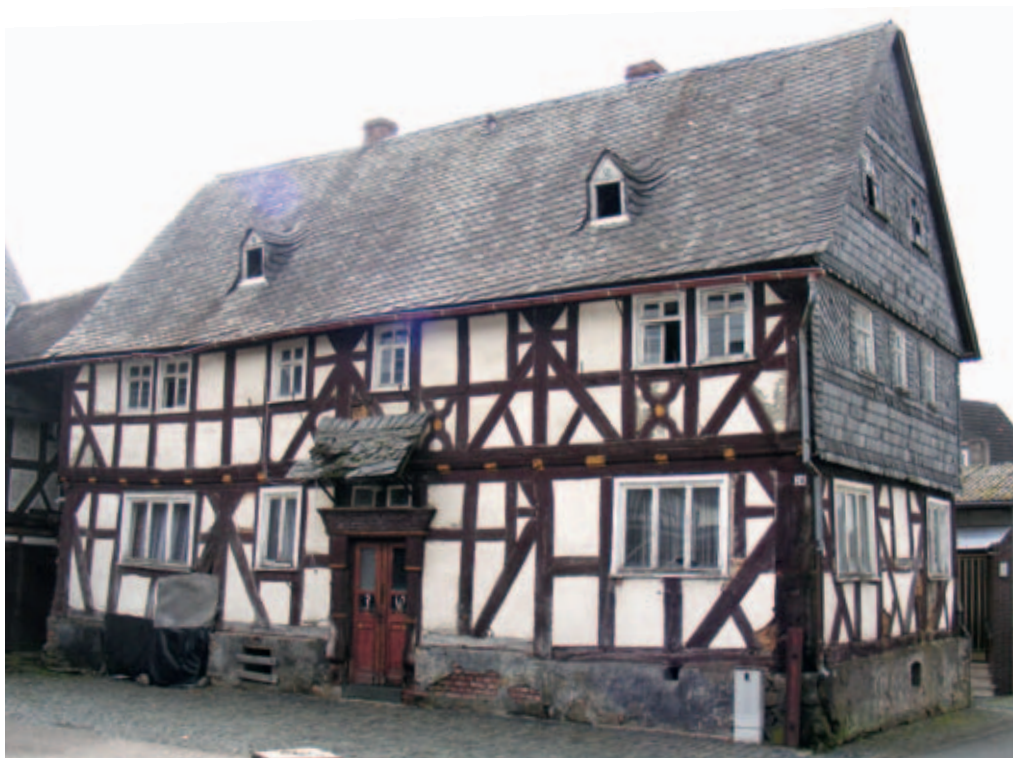
Schieferdach im Marburger Hinterland
