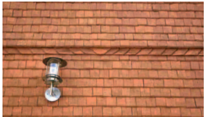
Eckige Lärchenholzschindeln in Oberhessen
