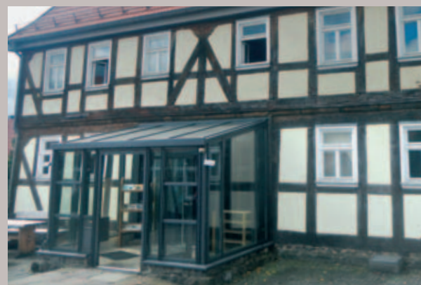
Schlichter Windfang an einem Kulturdenkmal in Hopfmannsfeld
