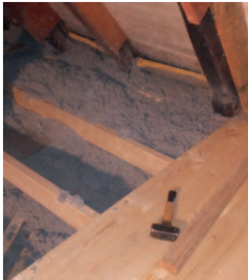
Aufdeckendämmung mit Nut und Federabdeckung.
